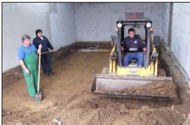
Jedna z brigád SDH - úprava podlahy před betonáží
